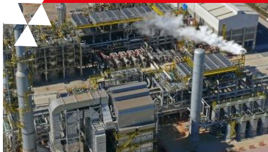
Equipamento Mecânico 252,784 toneladas
