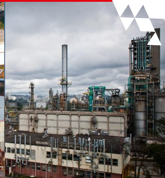
Construção de Plantas de Química e Petroquímicas
