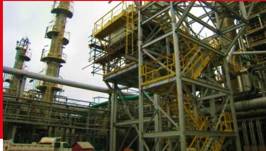
Estrutura Metálica 564,157 toneladas
